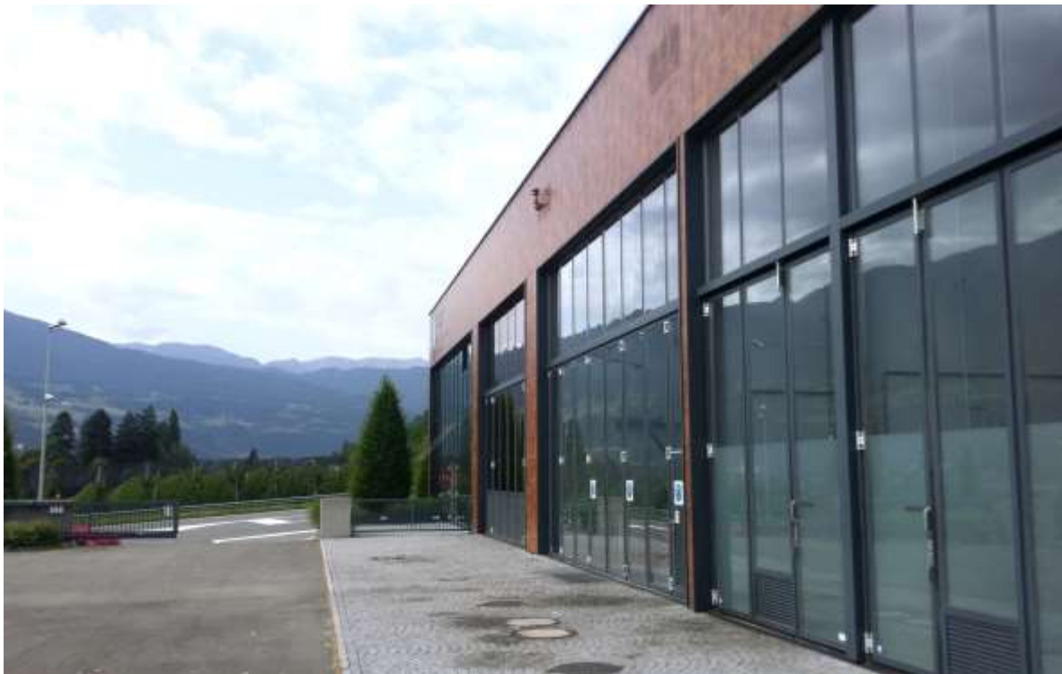
Heizzentrale Vahrn (Bestandsgebäude am Projektstandort)
